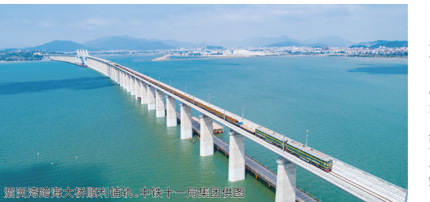
福厦高铁湄洲湾跨海大桥顺利铺轨。中铁十一局集团供图
