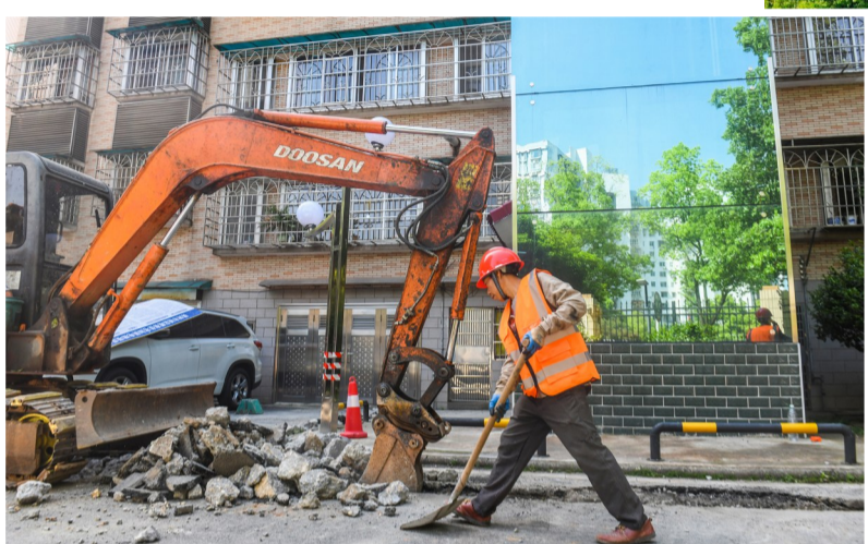
▼ 白鹤园小区管网改造现场。
