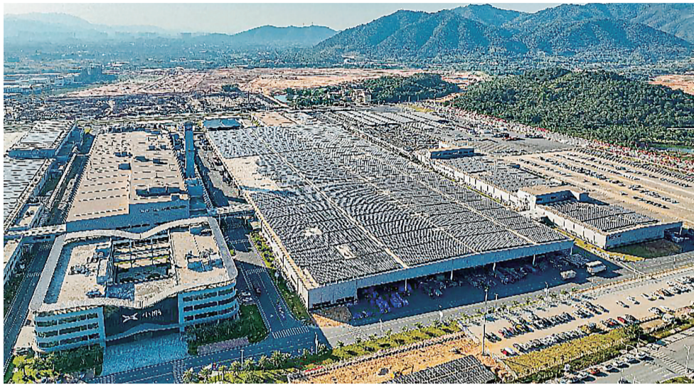
小鹏汽车智能网联科技产业园开展的分布式光伏发电项目。
