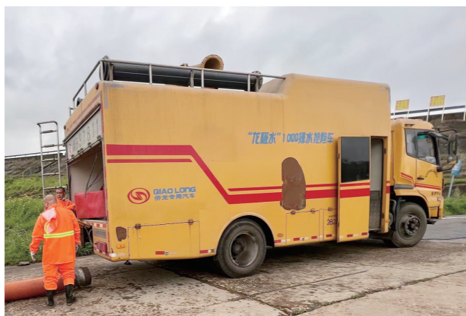
“龙吸水”设备助力高效排水。记者/伍靖雯 摄
