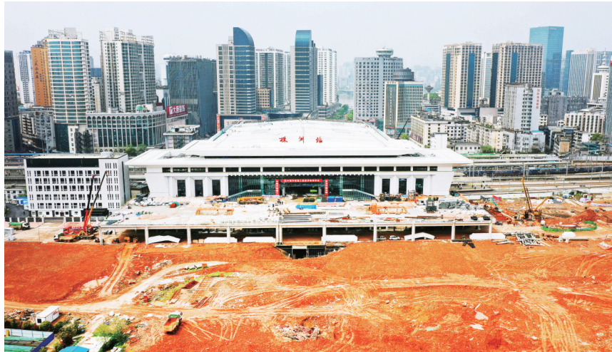
▲株洲火车站东站房主体结构已经完工。株洲晚报融媒体中心记者/谢慧 摄
