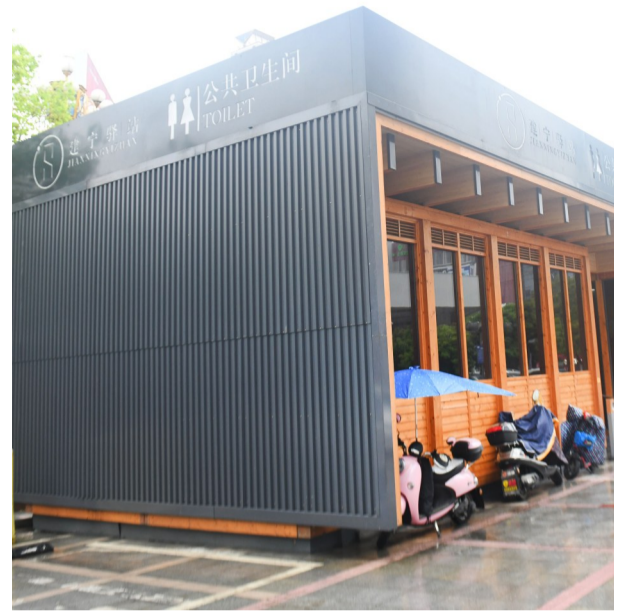
采用钢结构装配式的建宁驿站。株洲日报·掌上株洲记者/谢慧 摄
