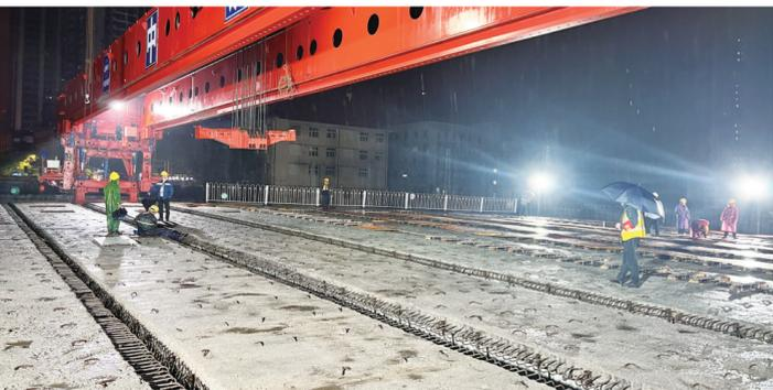
3月30日凌晨3时许,随着最后一片箱梁的成功落位,新华桥第三跨的12片箱梁全部架设到位,圆满完成第一阶段攻坚任务。
