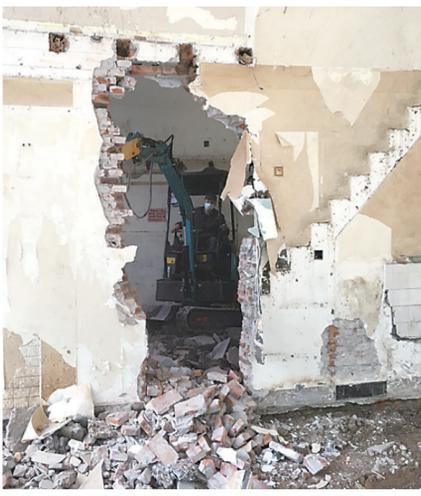
▲施工人员操作镐头机拆墙。记者/刘平 摄
