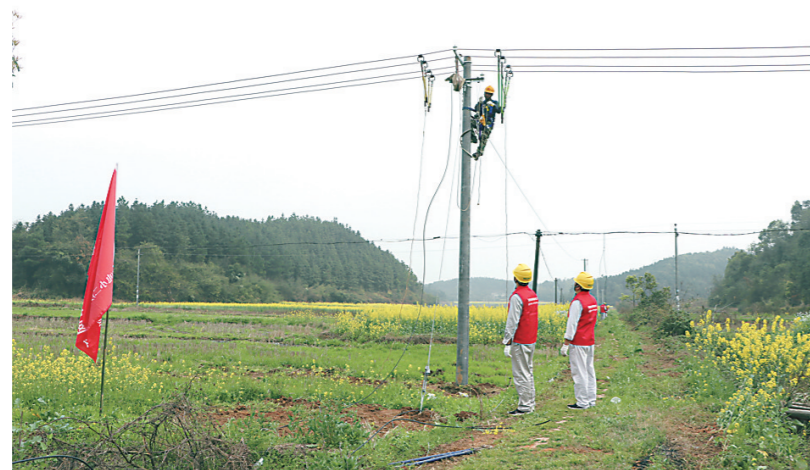
▲党员服务队正在施工。 通讯员供图
