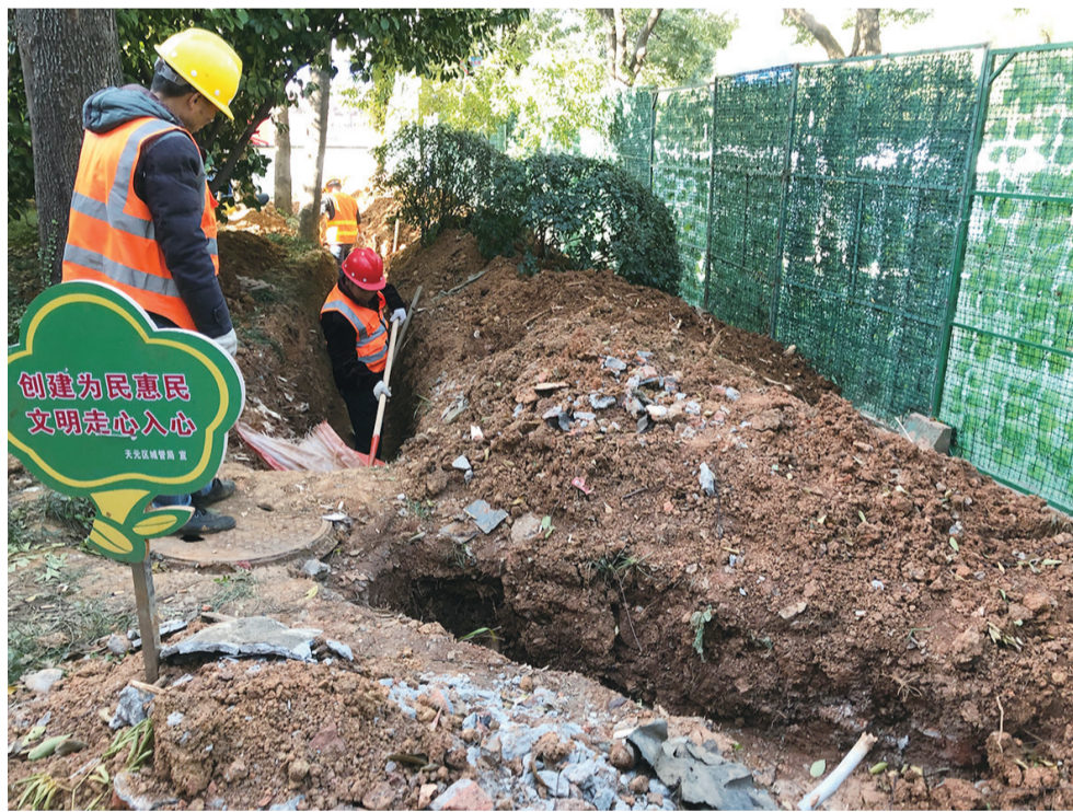
市内一处老旧燃气管网改造。吴楚/摄
