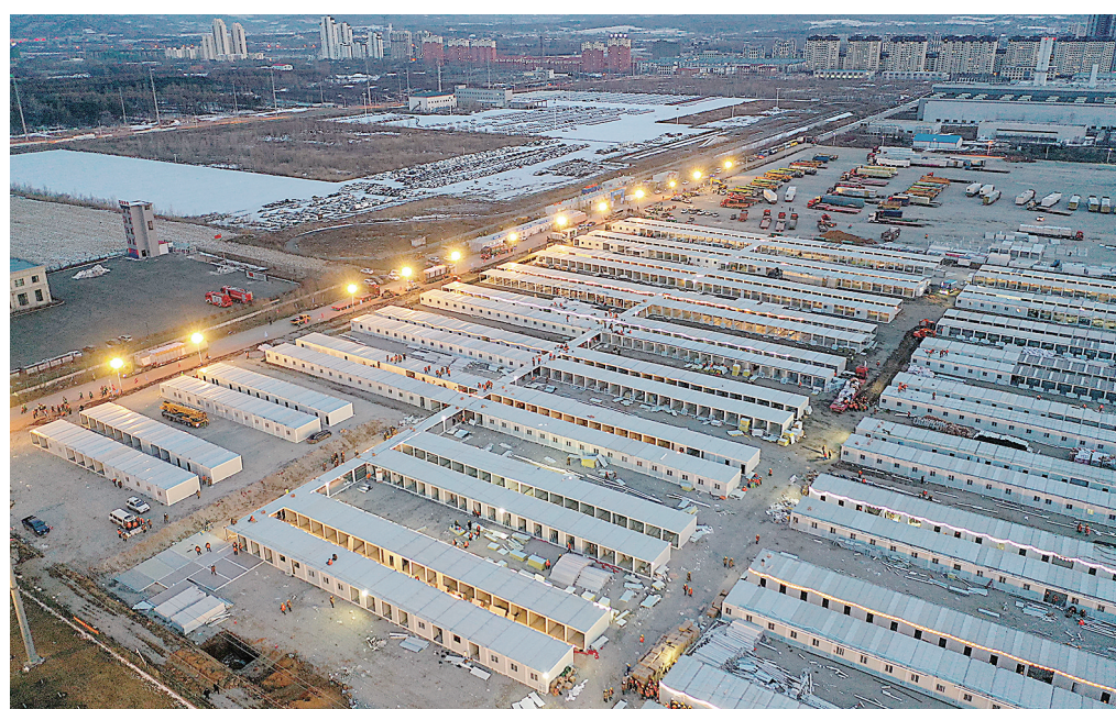
这是3月20日傍晚拍摄的吉林市高新南区隔离方舱建设现场(无人机照片)。建设现场看到,5000余名工人和百余台工程机械加班加点同时施工作业,为工程建设提速。新华社记者 张楠 摄
