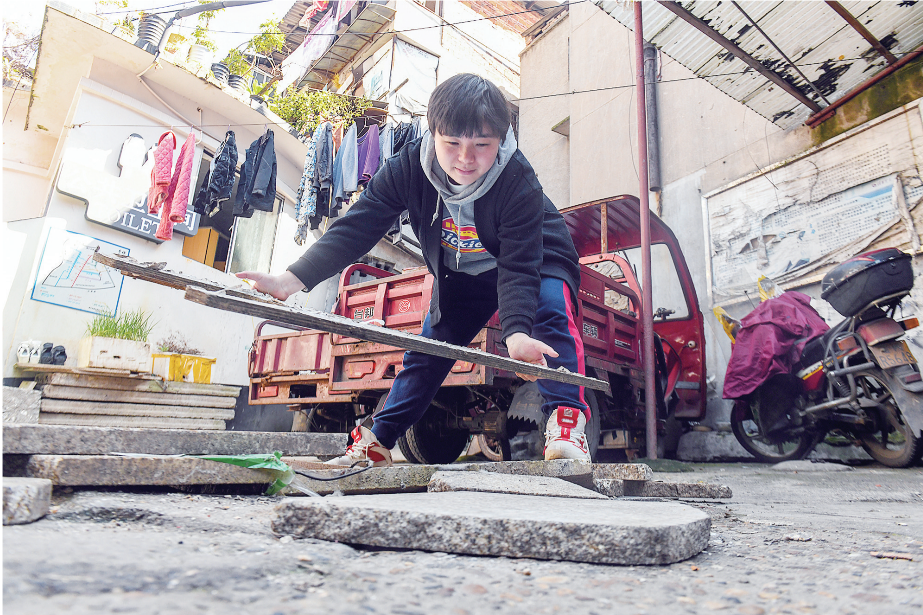
李家坪的一处井盖压坏了,赶紧找来木板临时盖上。
