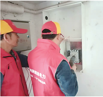
▲工作人员为西塘坪村敬老院进行表计增容。 通讯员供图
