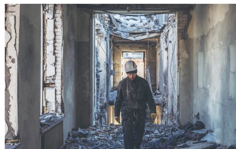
▲3月13日,在乌克兰哈尔科夫,消防员在一处建筑内工作。新华社发/迭戈·埃雷拉 摄
