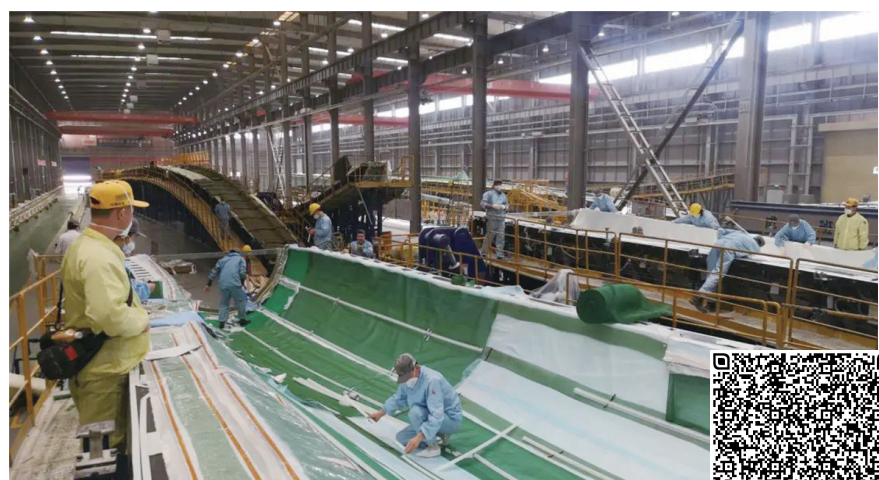
叶片生产现场。
