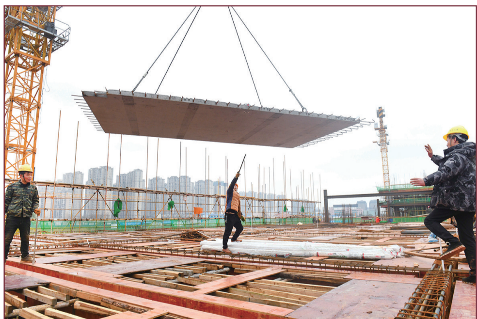
莲花中学建设现场,建筑工人们正在吊装楼板。
