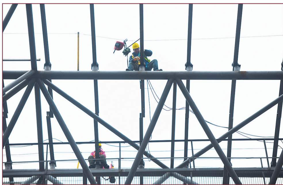
火车站改扩建施工现场,焊接工人顶着寒风在高空作业。
