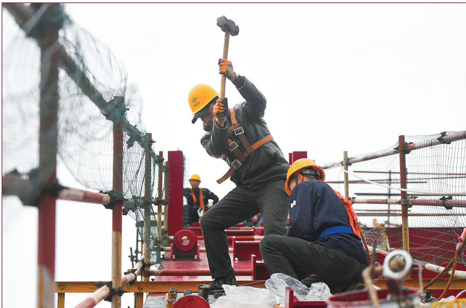
清水塘大桥施工现场,工人抡起大锤加固螺栓。
