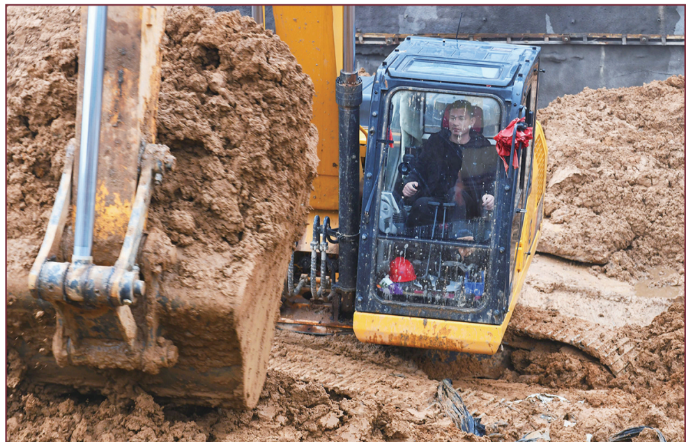
长江广场,土方施工区的挖机手正在作业。
