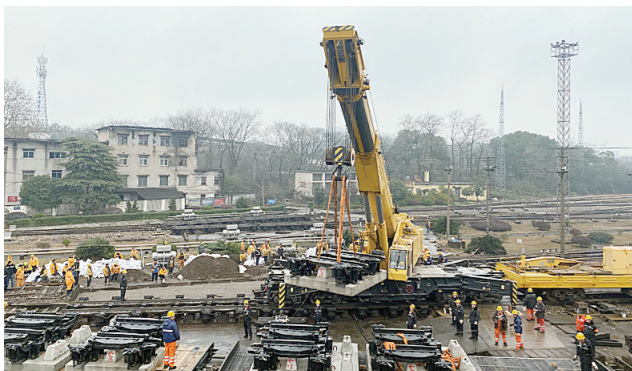
株洲北站二场驼峰缓行器大修施工现场。通讯员供图
