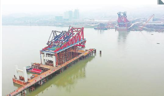
2月16日，清水塘大桥建设进行主拱杆件吊装。该项目于2月8日(农历正月初八)复工，南北岸共有80多名工人施工。目前，南岸拱吊机正在进行主拱杆件吊装，南岸在安装主拱杆件和拱吊吊机调试。预计2022年底主体贯通。株洲日报·掌上株洲记者/谢慧报
