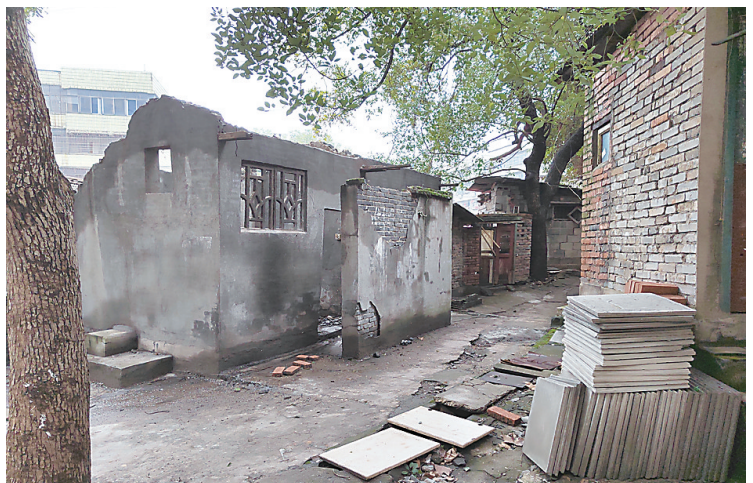
▲庆云山三村因老旧小区改造被拆除的公共厕所。记者/易楚瞳 摄
