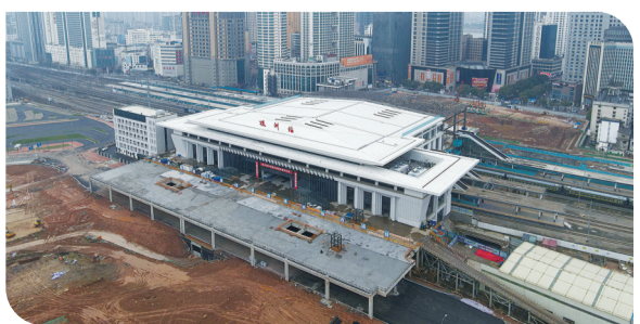
2月6日，火车站改扩建项目现场，钢结构施工已推进至三、四站台。 株洲日报·掌上株洲记者/张威摄
