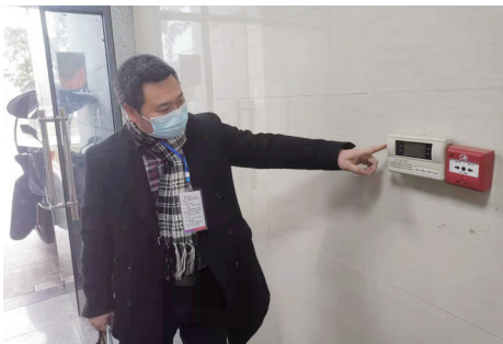
▲检查组在荷塘区某小区检查消防监控设备。受访者供图
