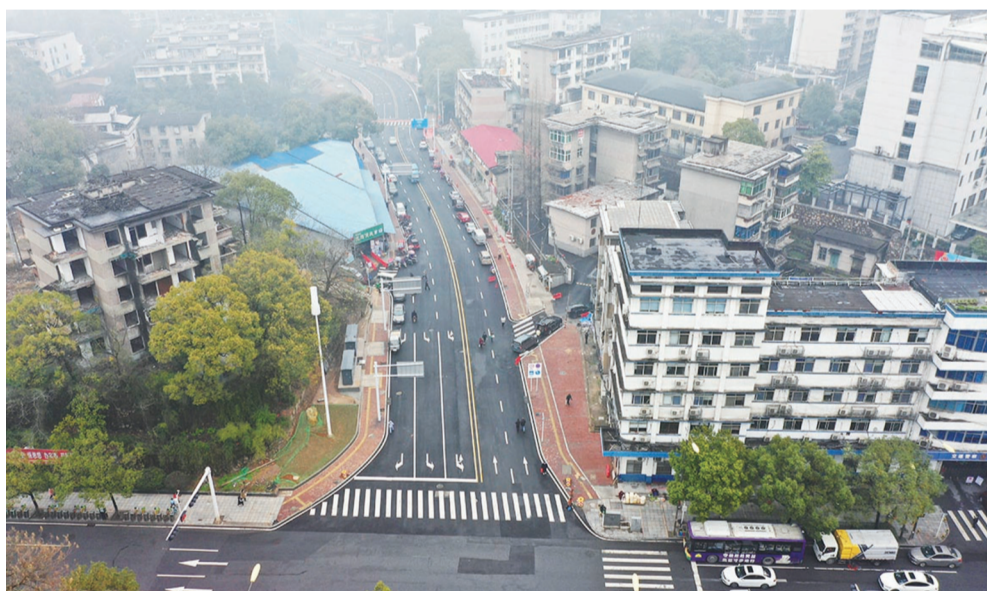
石峰区先锋路改扩建工程,南起建设北路,北至响田东路南辅道,全长576米。通过改造,原双向两车道改为双向四车道,路幅由6米拓宽至20米,极大优化了响石岭片区城市路网。图为1月19日航拍改造后的先锋路。 株洲日报社·掌上株洲记者/谢慧 摄
