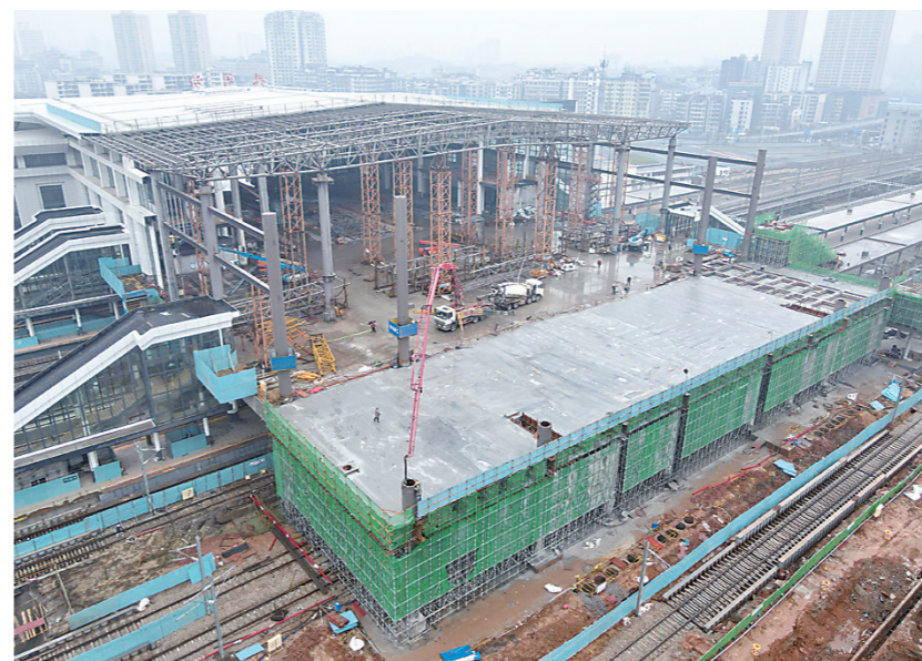
▲施工现场。 通讯员/邓智 供图
