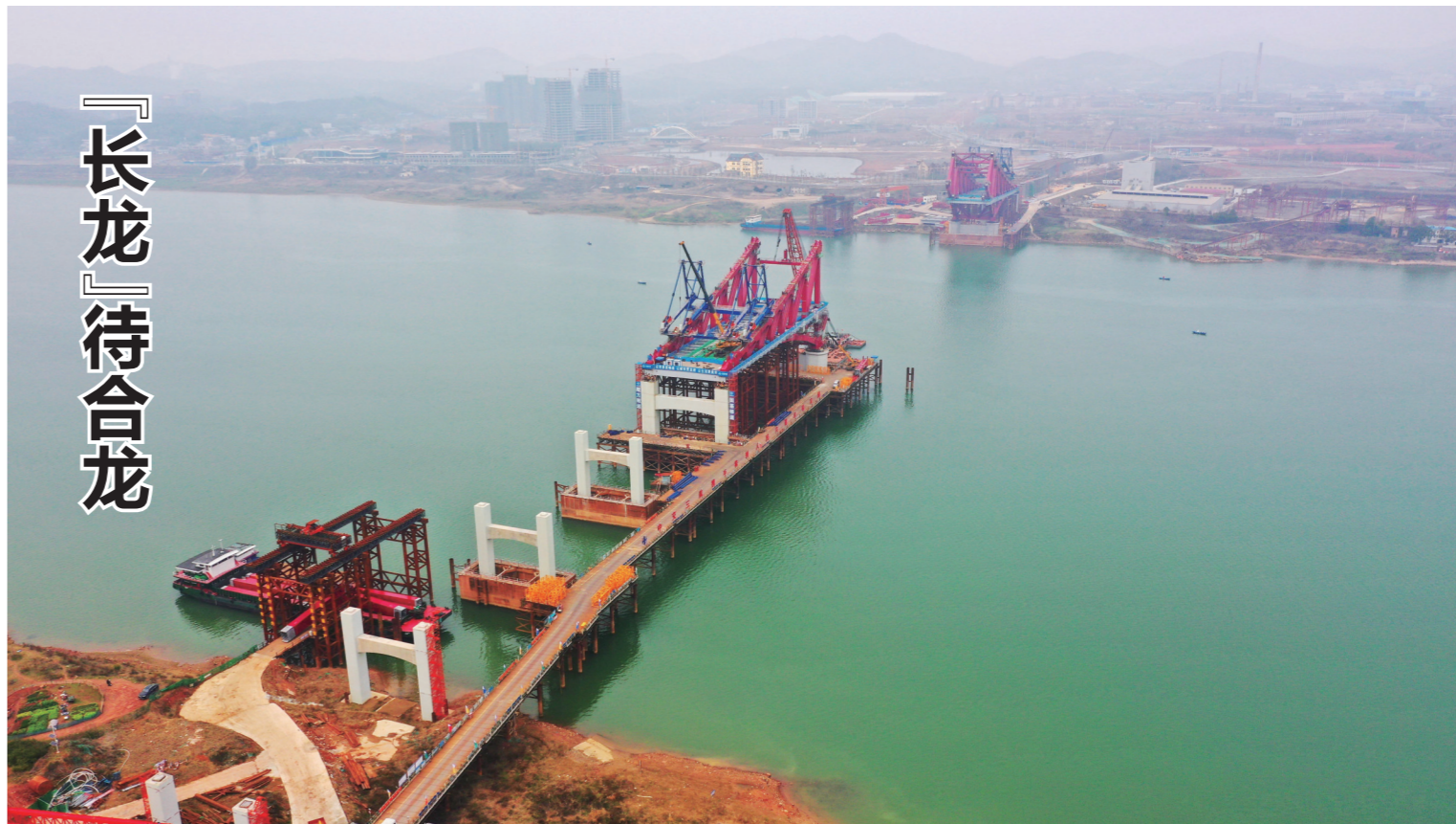
1月13日,清水塘大桥建设现场一派繁忙景象。目前大桥下部结构承台、墩柱施工已完成90%。大桥上部结构现浇梁南北引桥完成60%,大桥上部钢结构南北岸边跨安装完成。
