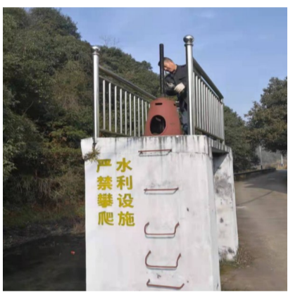
大京水库灌区水利设备维修现场。通讯员供图
