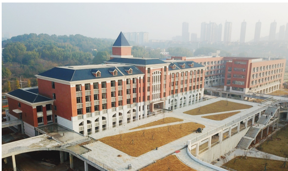
建设中的枫溪学校(航拍)。戴凉 摄
