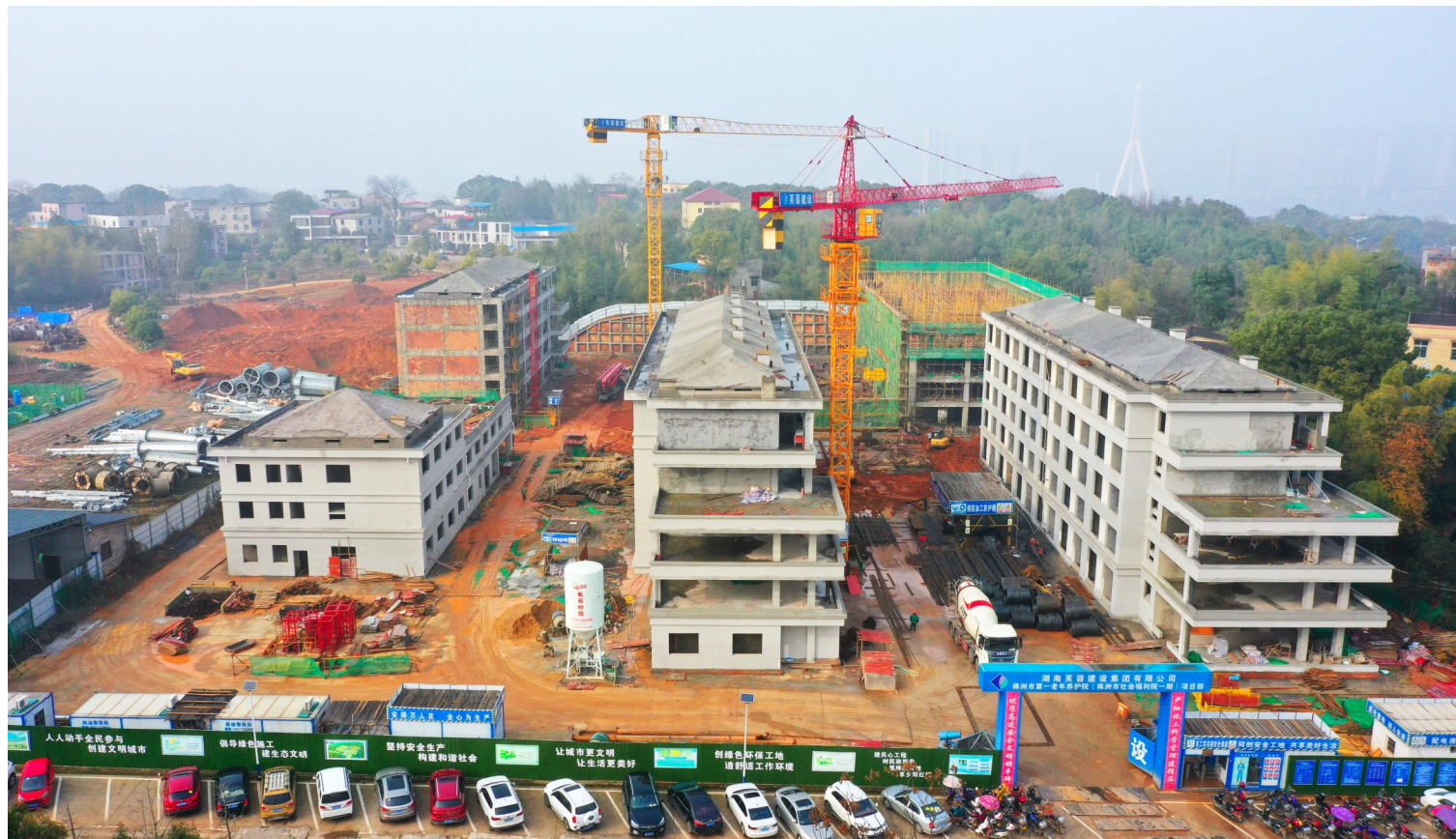
▲株洲市第一老年养护院项目是市社会福利院项目的一期工程,位于南环线旁的芦淞区曲尺村,占地面积约25亩,规划床位数448张,按照“医养结合”方向进行功能布局。目前,项目已经有4栋建筑进入装饰阶段,还有2栋将于本月底主体封顶。整体工程预计4月完工。
