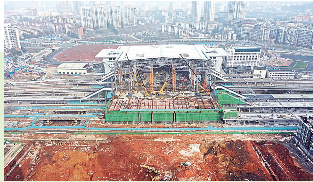
▲1月11日,株洲火车站改扩建项目现场。 株洲晚报融媒体记者/谢慧 摄
