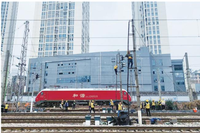
株洲火车站新计算机联锁开通大封锁施工现场。廖明摄
