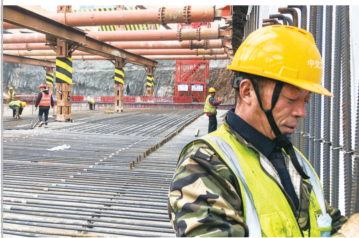
1月3日，在市铁东路和新塘西路新建工程项目施工现场，工人们在紧张工作，为早日恢复新塘路通车而努力。该项目由中交二航局承建。 株洲日报·掌上株洲通讯员/储沛沛 摄
