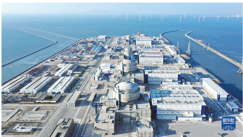
这是福清核电工程现场图(2021年12月1日摄,无人航机照片)。新华社发
