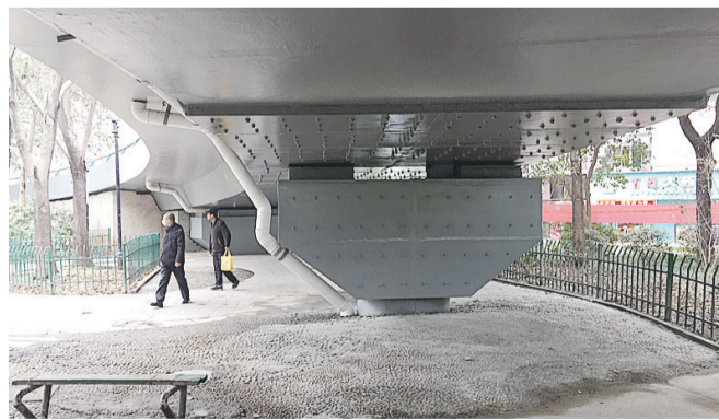
引桥下的受损桥墩得到修复、加固。株洲日报·掌上株洲记者/刘平摄
