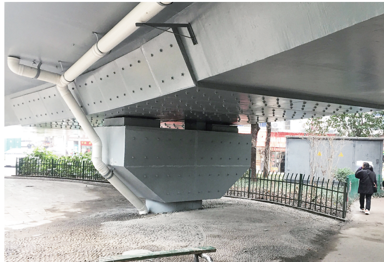
引桥下的受损桥墩得到修复、加固。记者/刘平 摄
