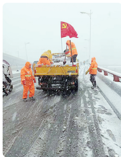
市市政工程维护中心应急队员在路上融雪除冰。 通讯员/供图
