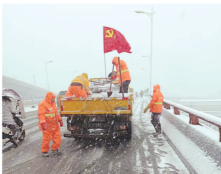
▲市市政工程维护中心应急队员在路上融雪除冰。 通讯员供图
