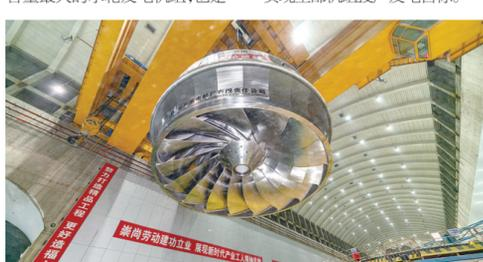
这是白鹤滩水电站最后一台机组——9号水轮发电机组转轮吊装现场(12月19日摄)。新华社发 张禾摄
