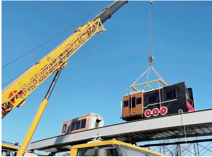
▲正在吊装落车的“双林寺号”主题列车。 企业供图
