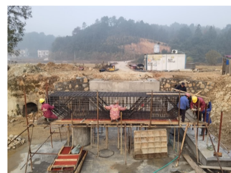
醴陵将军村三线桥拆除重建工程正在火热施工。株洲日报·掌上株洲通讯员/黄卫正 供图
