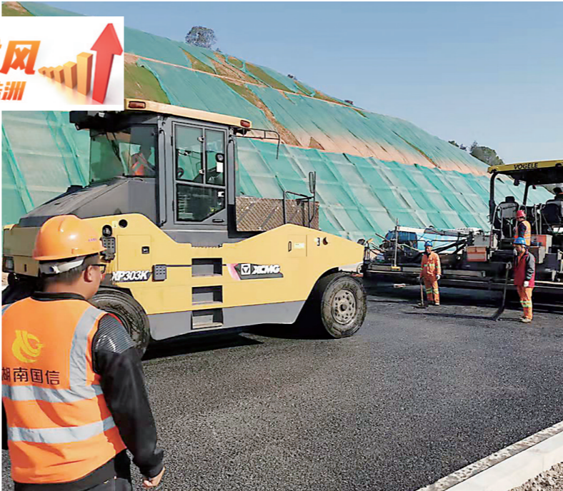
中车大道正在进行最后一层沥青的铺设作业。
