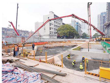
12月14日,铁东路和新塘西路新建工程项目部传来消息,铁东路隧道一号基坑顶板混凝土浇筑顺利完成,标志着铁东路隧道一期主体工程完工。
