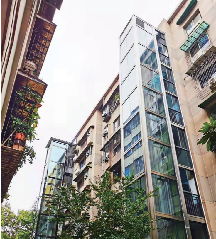
▲人大小区安装的电梯。通讯员供图
