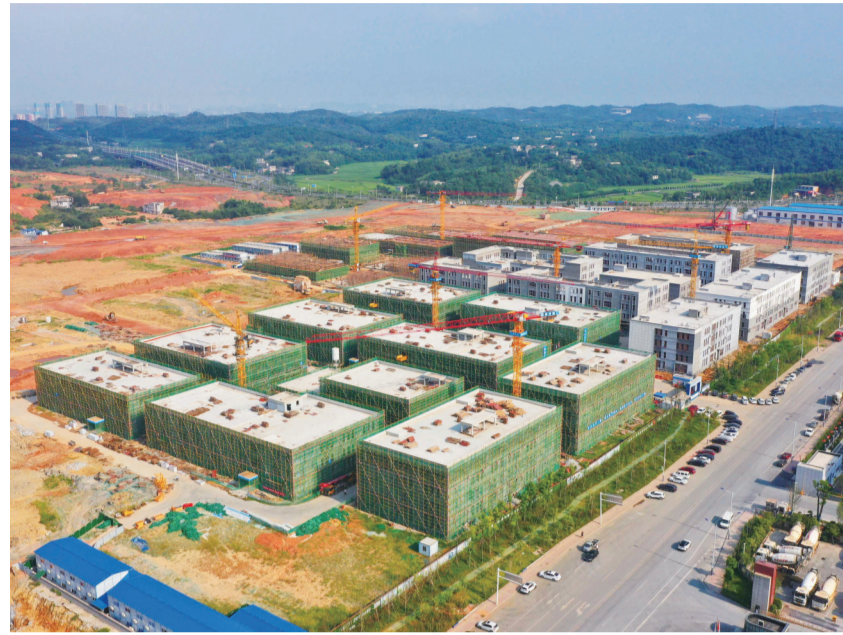
建设中的天元区中南高科产业园。记者/谢慧 摄
