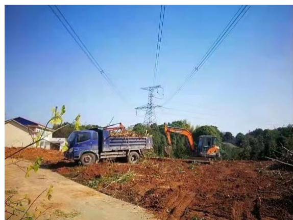
对威胁电网安全的“树障”进行清除 通讯员供图
