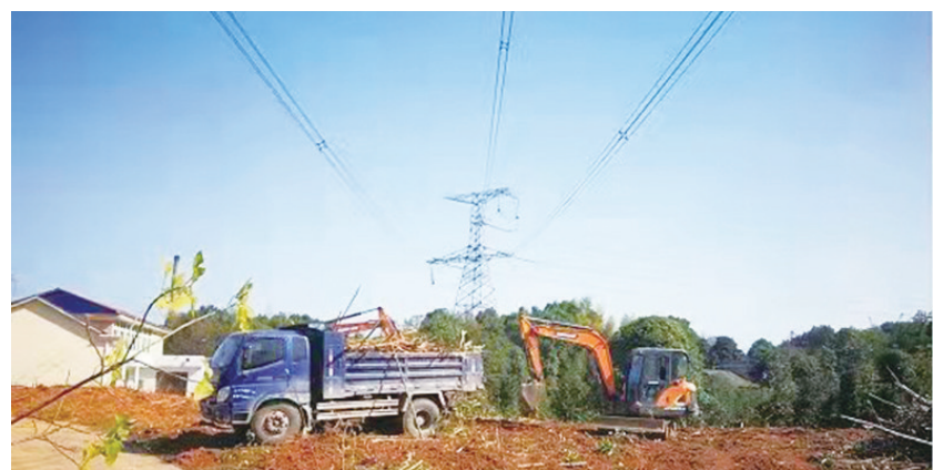
▲对威胁电网安全的“树障”进行清除。 通讯员供图
