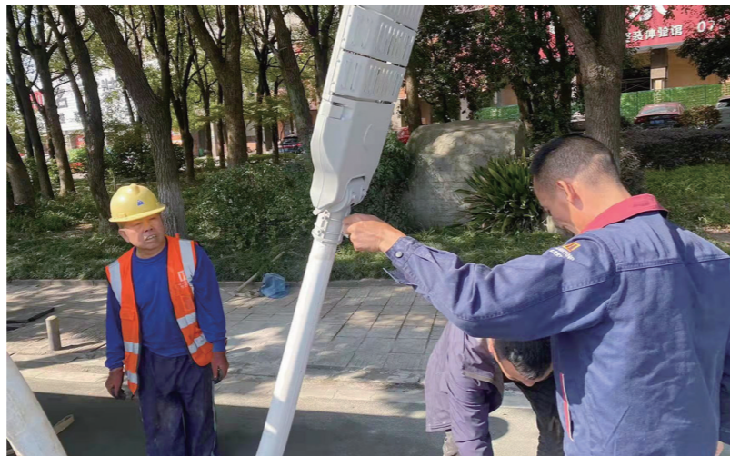
▲城区照明设施大中修改造进行中。 通讯员供图
