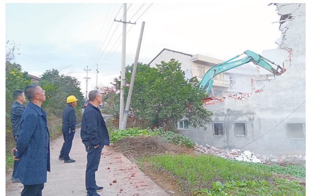
▲ 拆迁现场。通讯员供图
