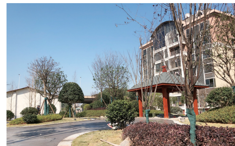
▲2月22日,芦淞区古大桥安置小区内的微公园已完成基础建设。晚报融媒体中心记者张威 摄
