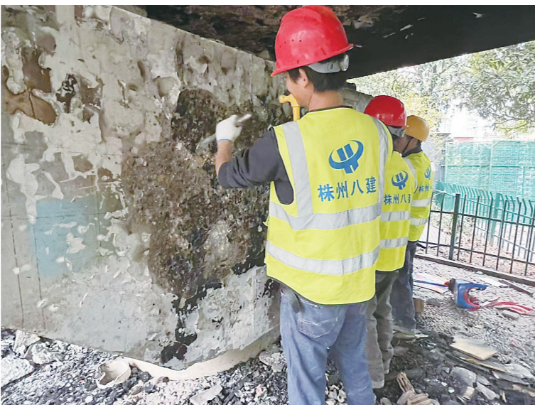
▲施工人员清理桥墩遭损毁的混凝土外层。伍靖雯/摄
