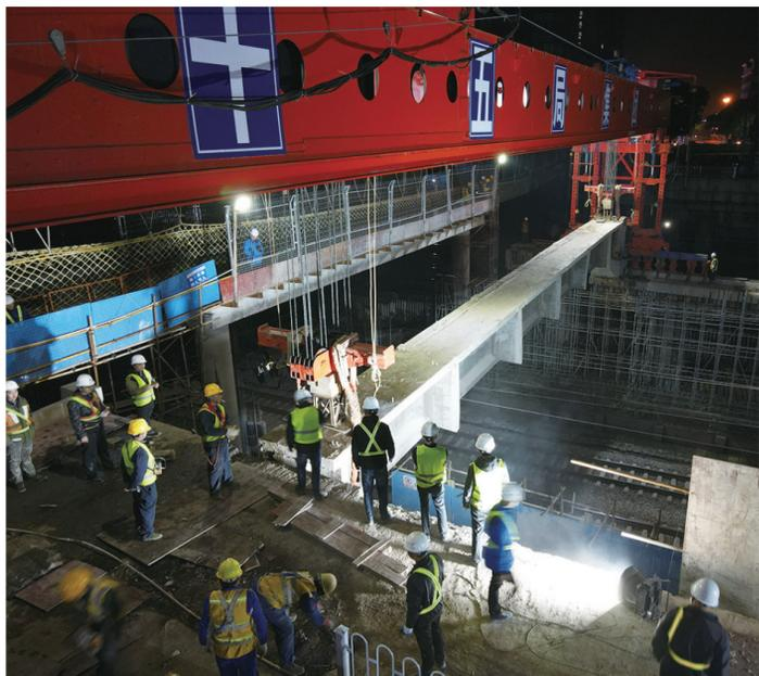
新华桥东侧最后一块T梁吊离施工现场。 通讯员/唐文健 摄
