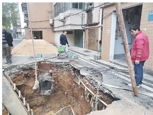
▲银苑小区正在施工中的电梯基坑。记者/成姝兰 摄
